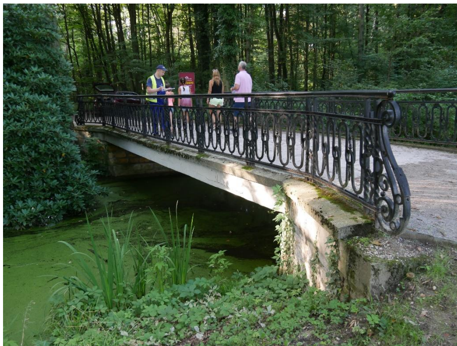
Fot. 10. Gzyms od strony zachodniej na przyczółku od strony Alei Lipowej (podpora 2). Ubytki gzymsu na końcu skrzydelka
