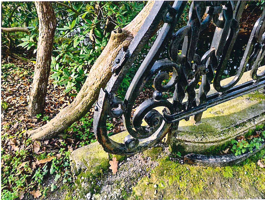
Fot. 9, 10, 11, 12, 13. Uszkodzenia skrzydełek z widocznymi ogniskami korozji na elementach balustrady
