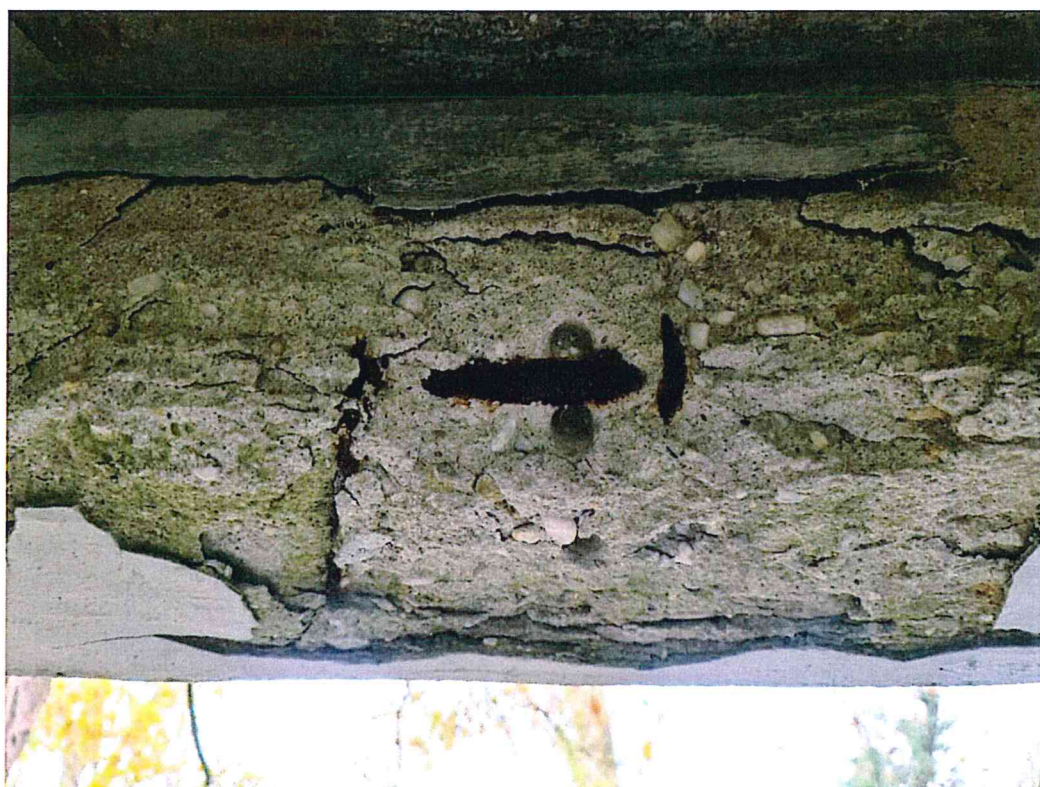
Fot. 4, 5, 5, 6, 7, 8. Uszkodzenia płyty pomostowej i belki gzymsowej oraz korodujące pręty zbrojenia i stopki dźwigarów
