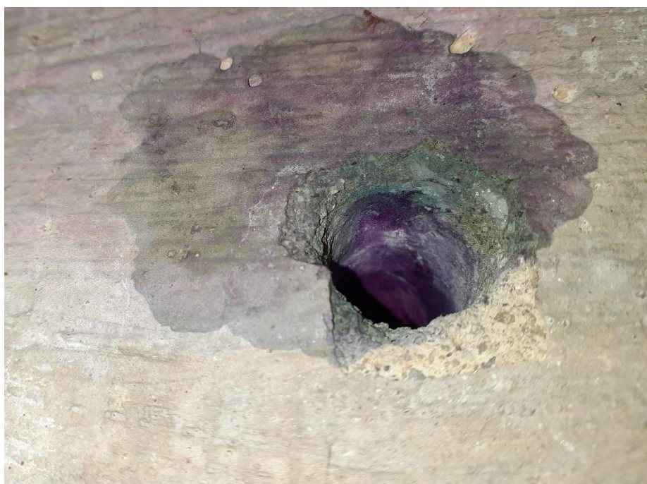
Fot. 2. Zbliżenie na otwór w miejscu pomiarowym nr 3 – spód płyty pomostu.
