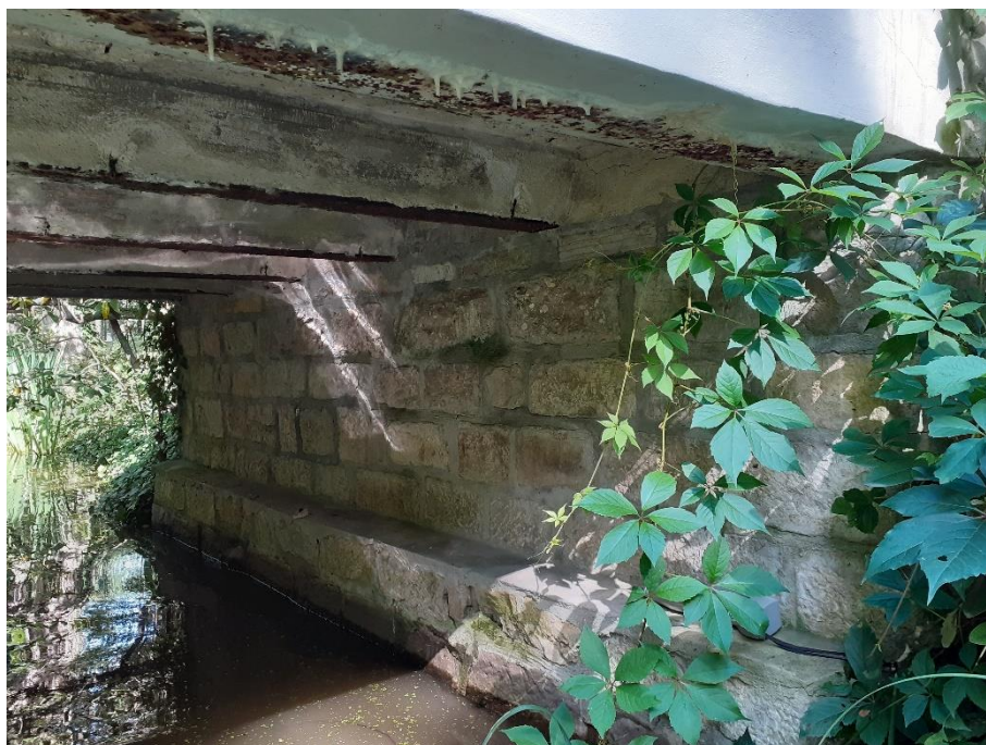
Fot. 4. Widok przyczółka północnego – typowy widok podpory.
