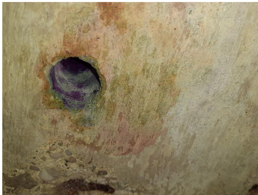
Fot. 1. Widoczny odwiert w miejscu pomiarowym nr 2 – spód płyty pomostu.
