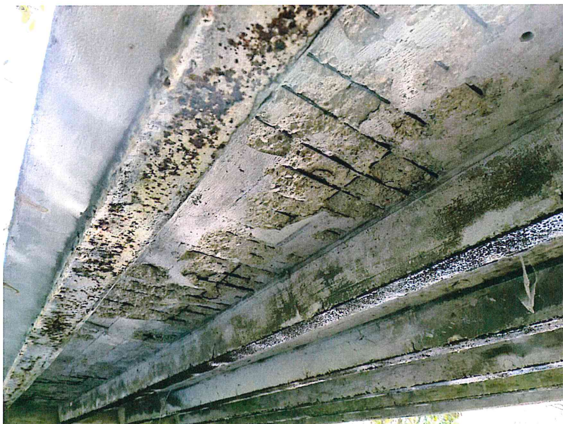
Fot. 2. Widok stopek dźwigarów nośnych i płyty
