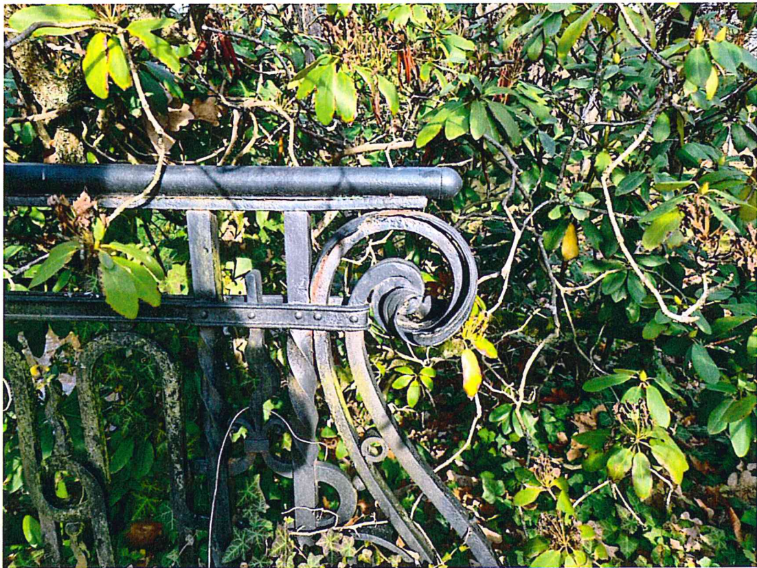
Fot. 8, 9, 10. Ogniska korozji na balustradzie
