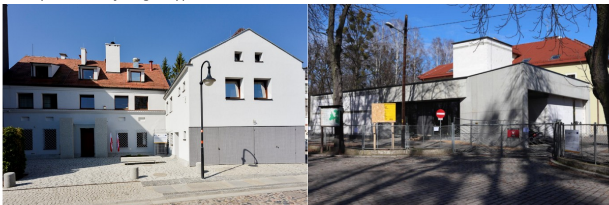
Ryc. 9 Budynek CMJW w Opolu, ul. Minorytów 3 – widok wyremontowanej elewacji budynku i placu
