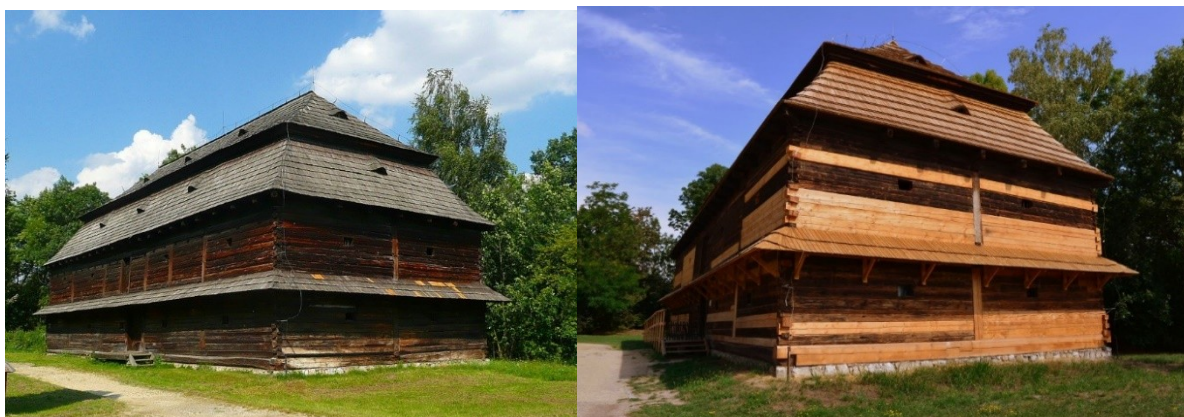
Ryc. 4 Muzeum Wsi Opolskiej w Opolu. Spichlerz dworski ze Sławęcice przed i po pracach remontowych, fot. ze zbiorów MWO w Opolu
