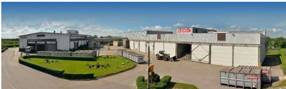
Rysunek 60. Widok na instalację MBP zlokalizowaną w Opolu 142
