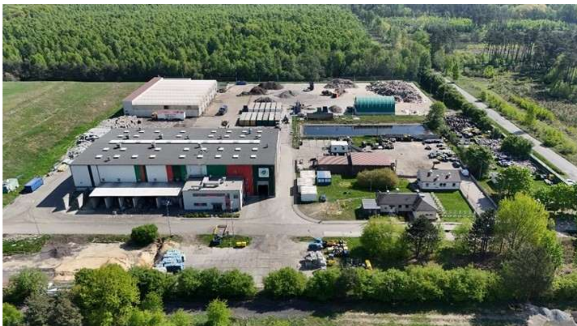
Rysunek 63. Widok na instalację MBP zlokalizowaną w Kędzierzynie-Koźlu 145
