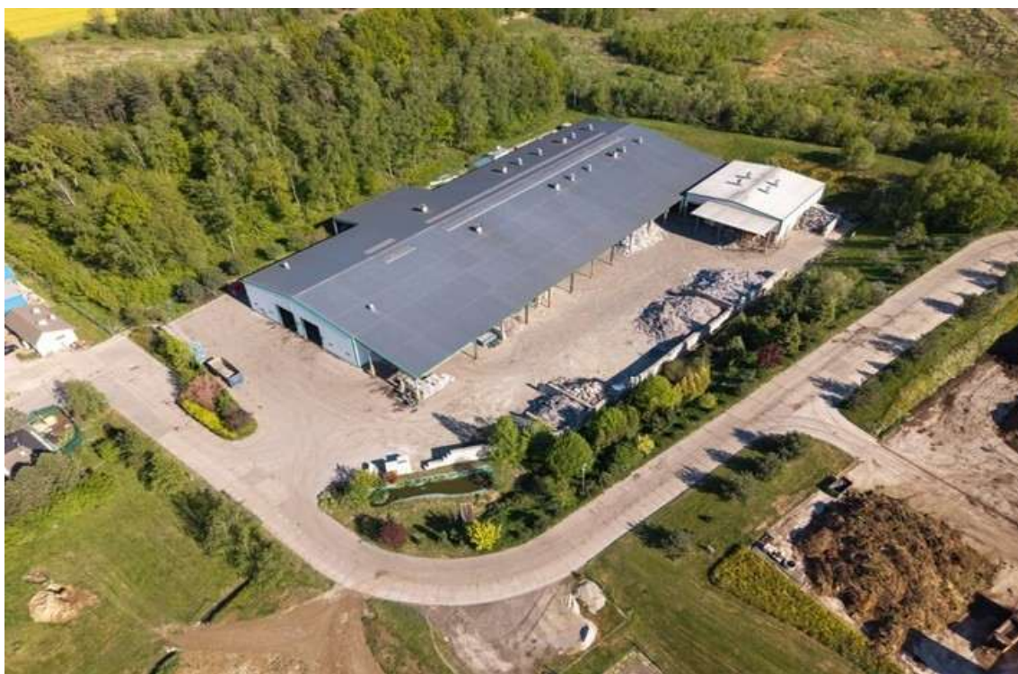
Rysunek 62. Widok na instalację MBP zlokalizowaną w Domaszkowicach gm. Nysa 144
