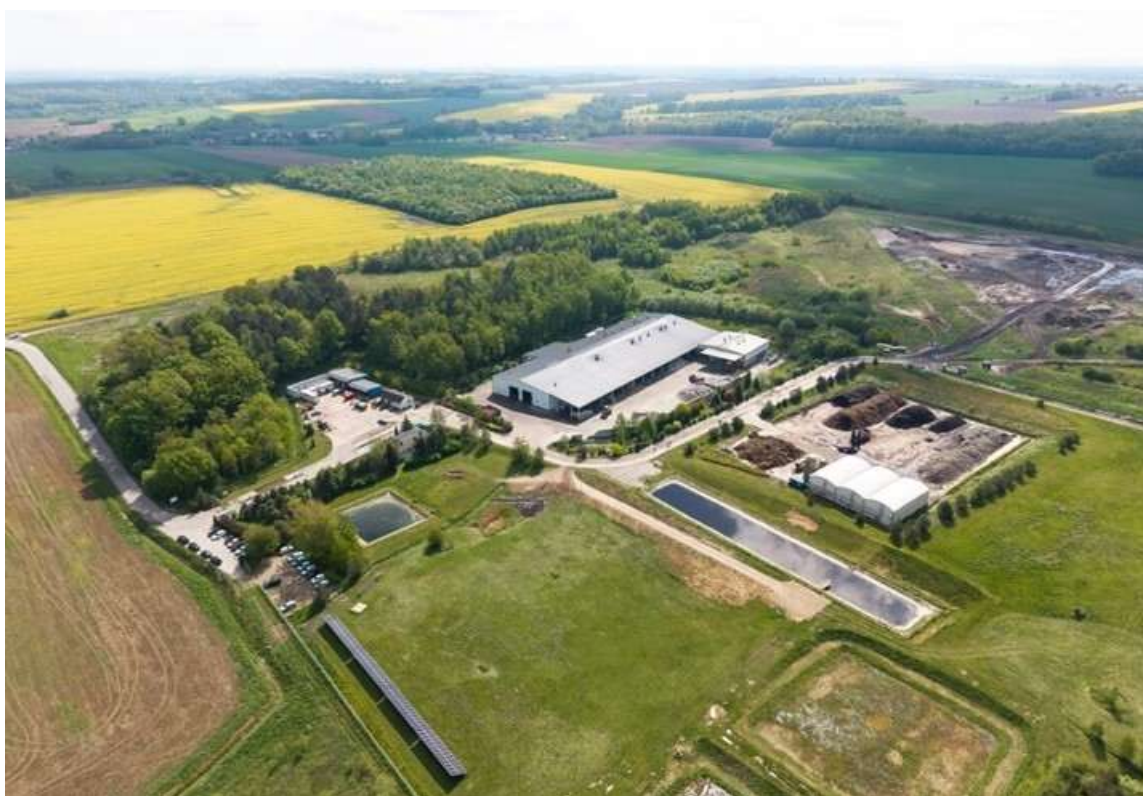
Rysunek 61. Widok na instalację MBP zlokalizowaną w Domaszkowicach gm. Nysa 143
