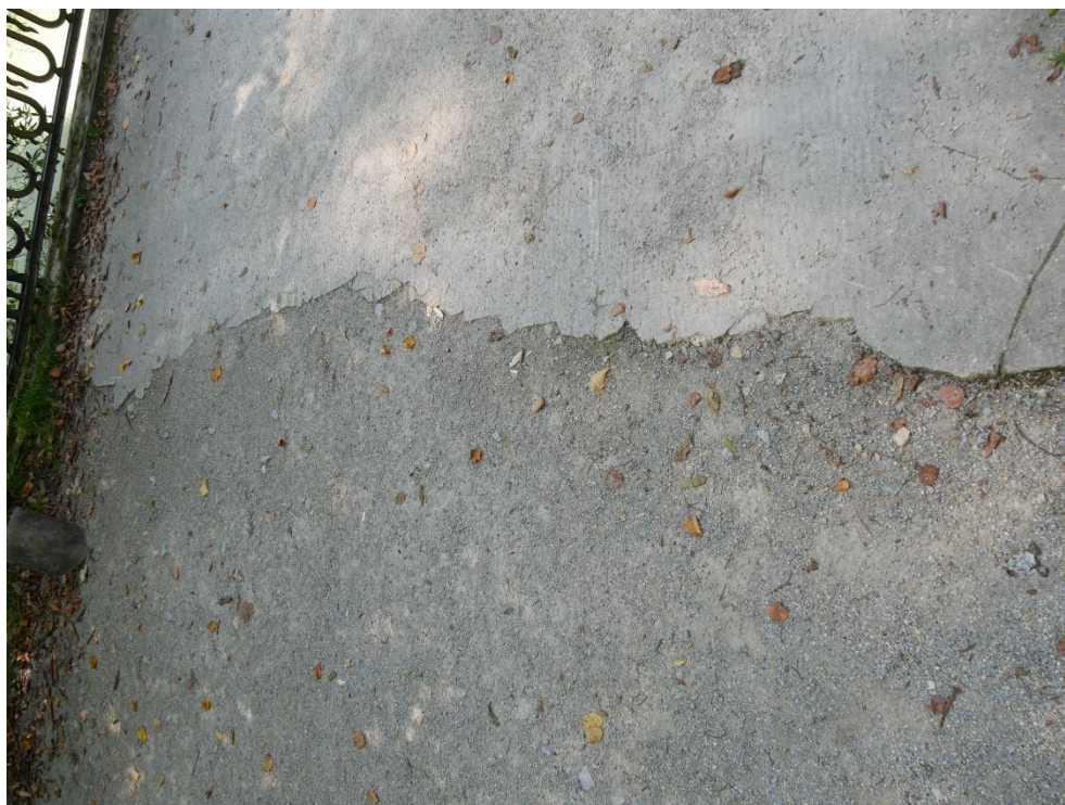
Fot. 6. Betonowa nawierzchnia mostu na połączeniu z nawierzchnią dojazdu do mostu.
