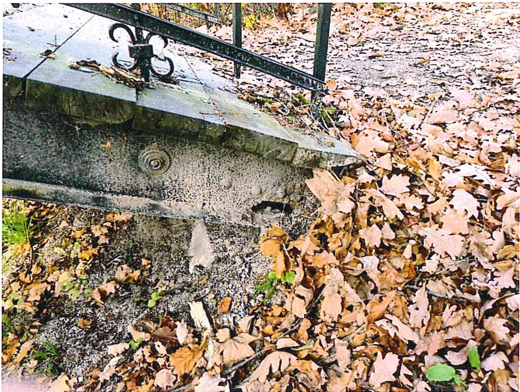
Fot. 3. Strefa podporowa, uszkodzony dźwigar
