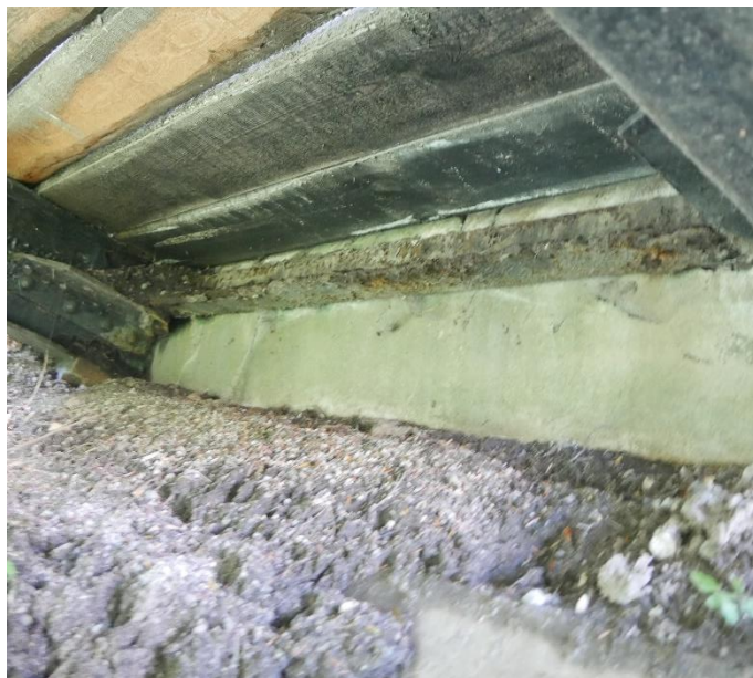
Fot. 15. Stężenie poprzeczne podporowe nad podporą po stronie wyspy miłości (podpora 2) Odkłady zanieczyszczeń i postępująca korozja stężenia
