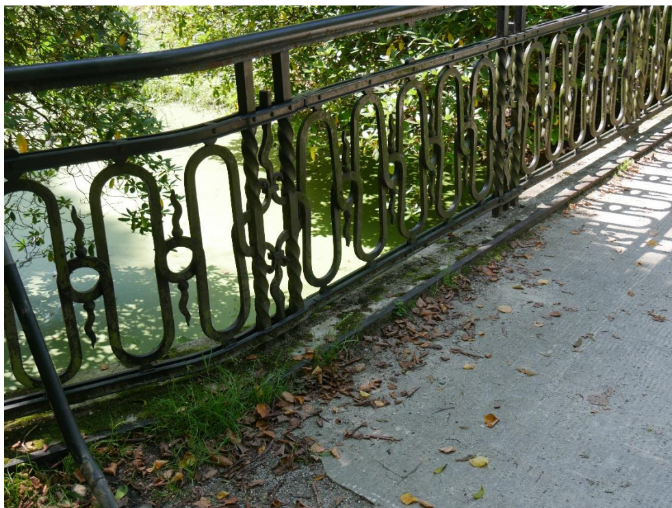
Fot. 7. Nawierzchnia i balustrada w obrębie dojścia od strony parku (podpora 2). Zanieczyszczenia i wegetacja roślin na nawierzchni w obrębie skrzydełka nad podporą
