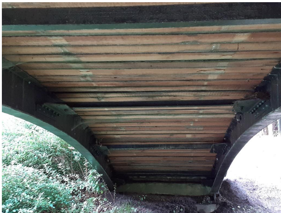
Fot. 10. Pomost i ustrój nośny od spodu kładki
