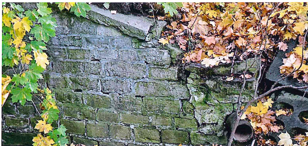
Fot. 8 i 9. Pękające skrzydełko z wylotem niezidentyfikowanego kanału
