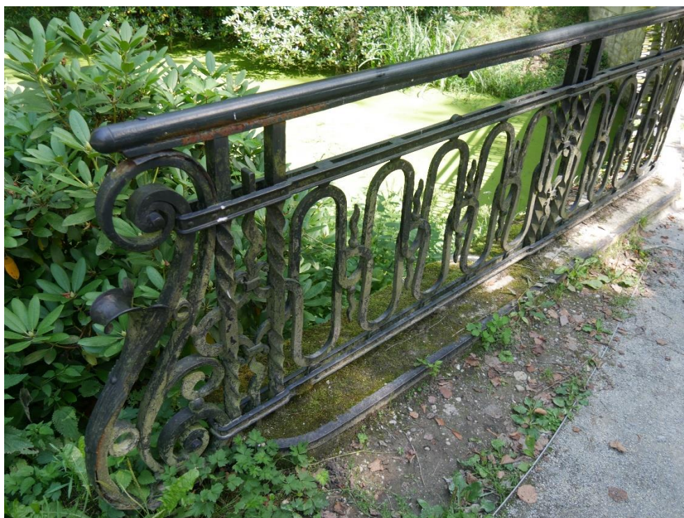
Fot. 8. Balustrada zachodnia w obrębie skrzydełka podpory od strony alejki Lipowej (podpora 1). Wegetacja mchów na belce gzymsowej oraz zanieczyszczenia balustrady i lokalnie wykwyty korozji.
