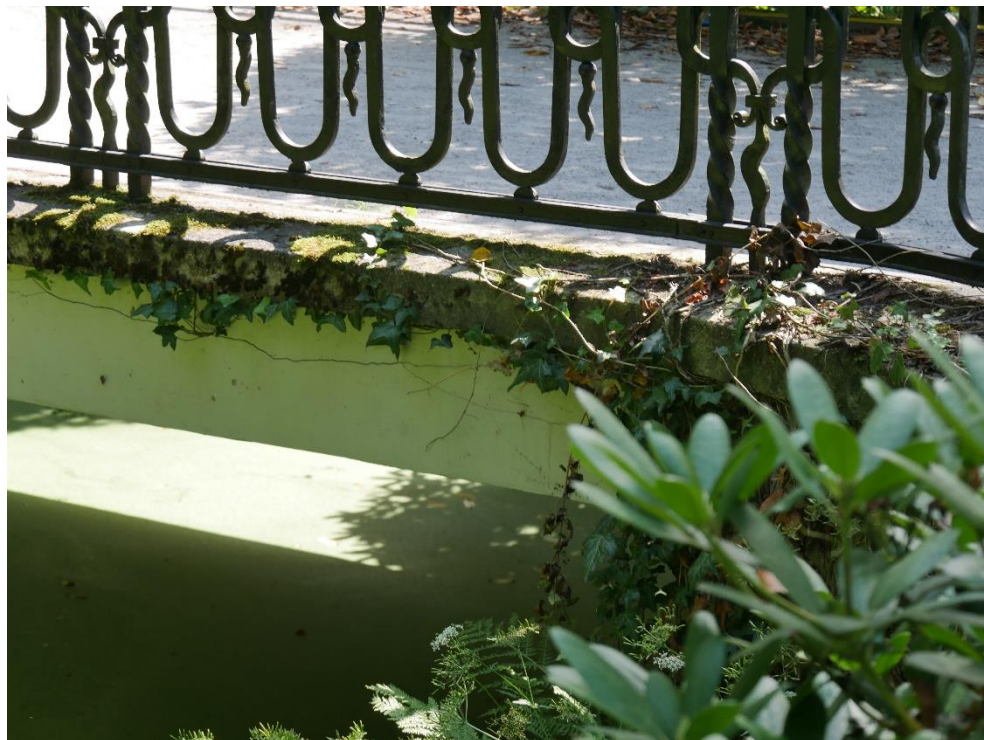
Fot. 9. Belka gzymsowa w obrębie podpory 1 po stronie wschodniej Zanieczyszczenia, spękanie oraz wegetacja mchów i roślin pnących na gzymsie
