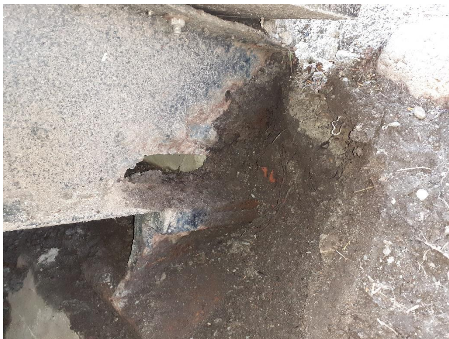
Fot. 16. Podparcie dźwigara południowego na podporze 2 Zaawansowana korozja wżerowa środnika dźwigara z dużymi ubytkami perforacyjnymi – powodem odkłady zanieczyszczeń i stale utrzymująca się wilgoć.
