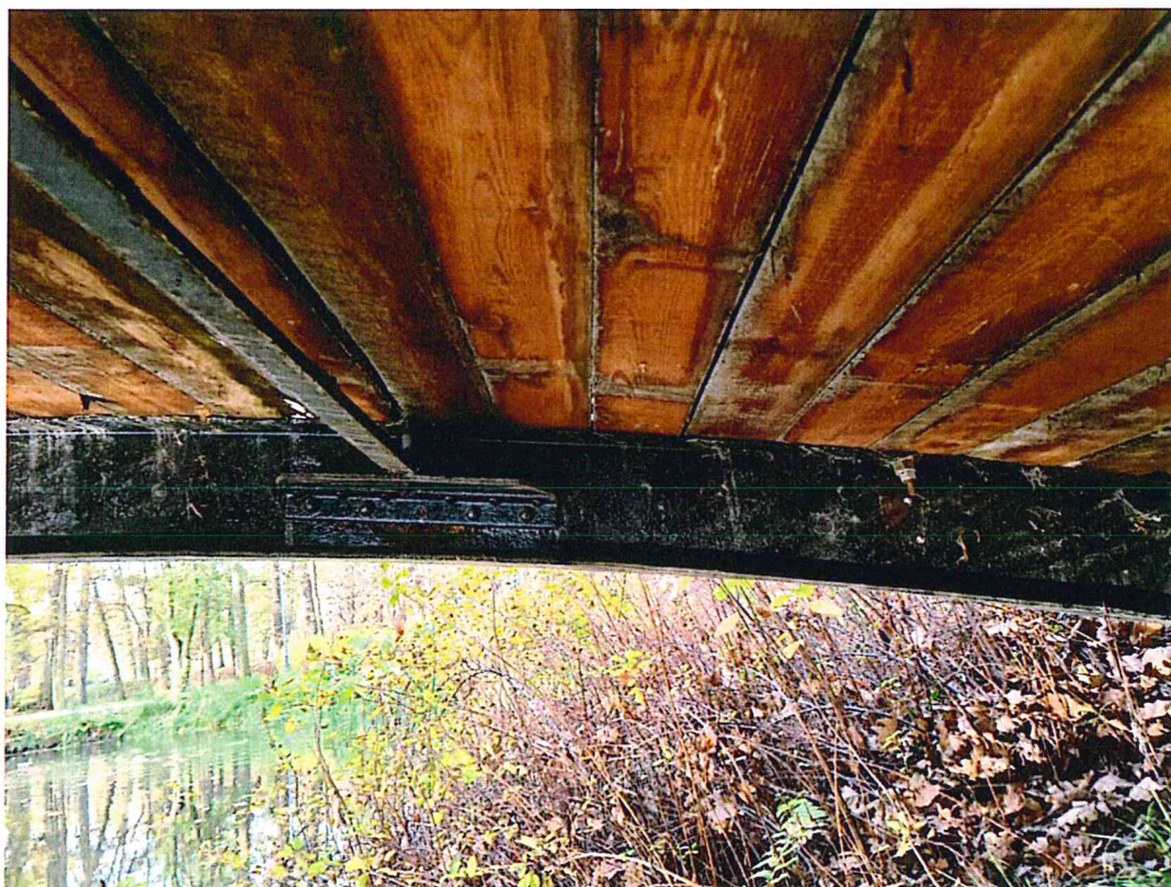
Fot. nr 5. Stężenie, dźwigar i deski pomostu deski pomostu
