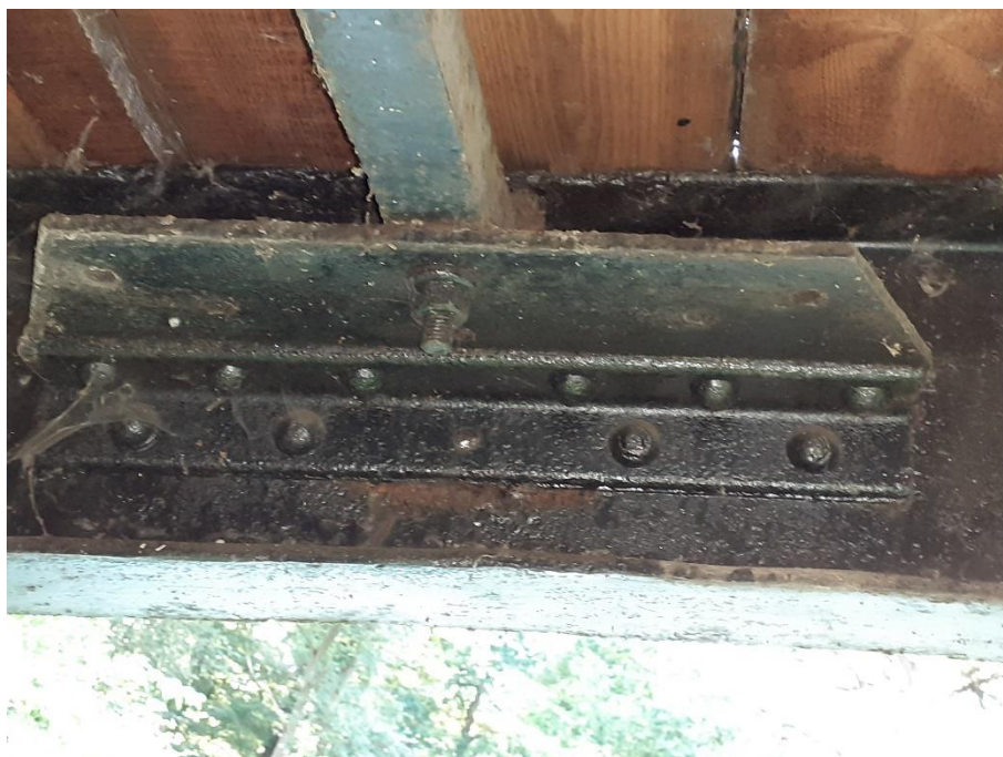
Fot. 14. Blacha węzłowa połączenia dźwigara ze stężeniem poprzecznym
