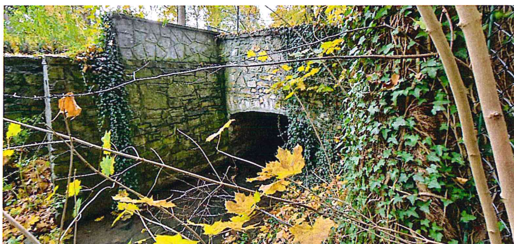
Fot. 8 i 9. Pękające skrzydełko z wylotem niezidentyfikowanego kanału
