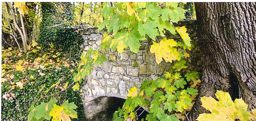
Fot. 6 i 7. Widok czoła mostu z drzewem rozpychającym skrzydełko
