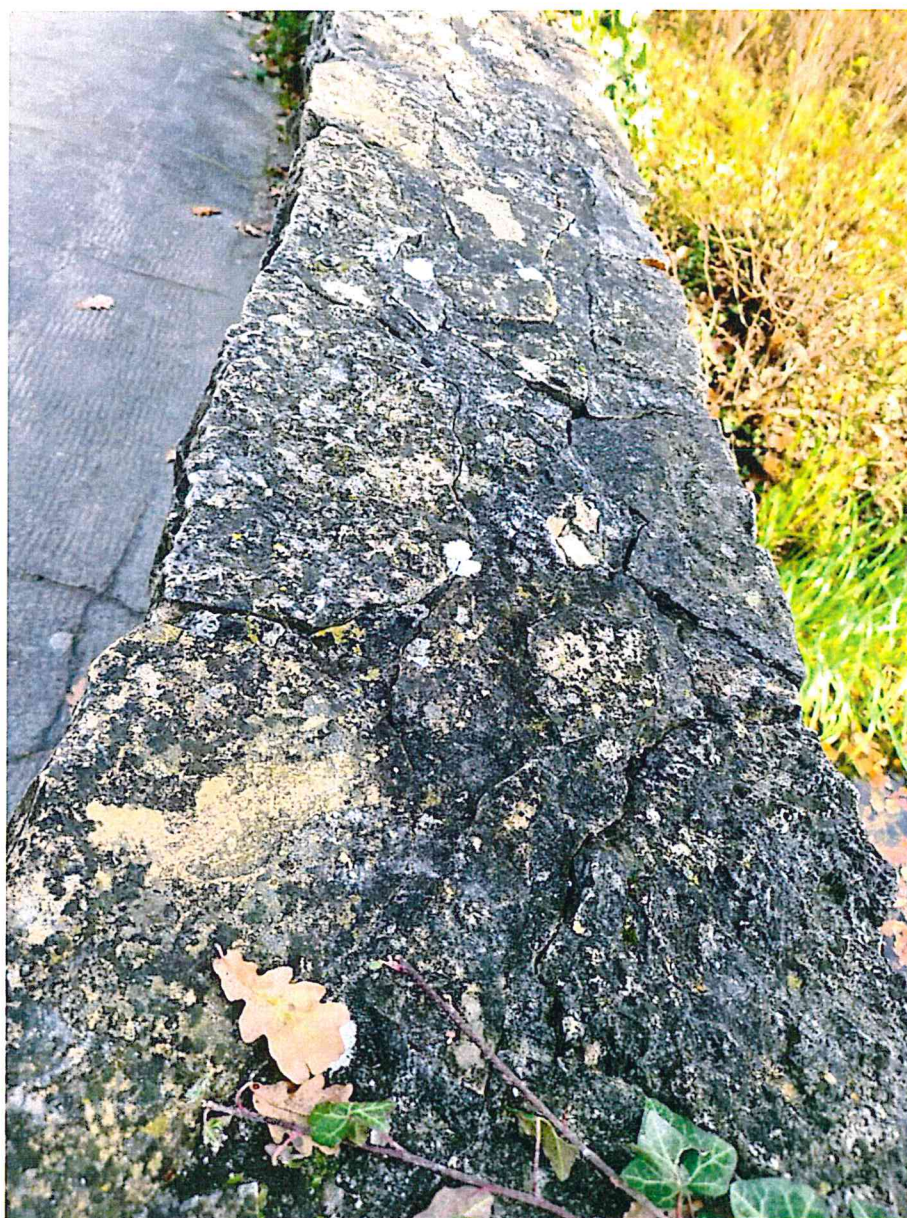
Fot. 4, 5, 5, 6, 7. Pęknięcia balustrad
