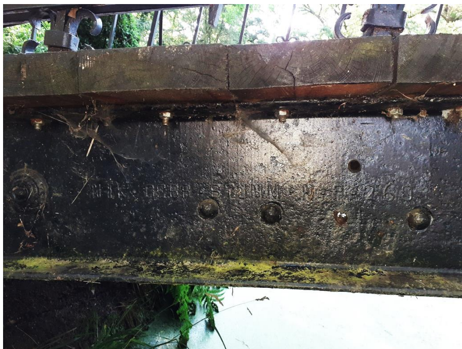
Fot. 11. Dźwigar prawy z naniesionymi symbolami oznaczającymi asortyment i pochodzenie dźwigara
