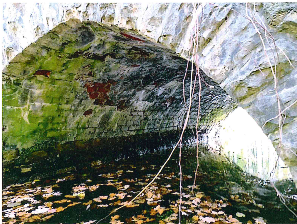
Fot. 2. Uszkodzenia podniebienia sklepienia
