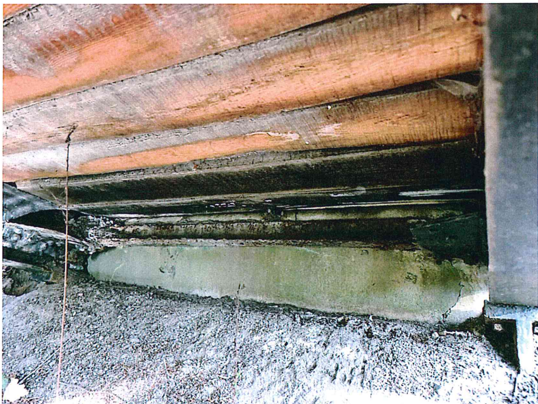
Fot. nr 4. Strefa podporowa, korodujące stężenie, deski pomostu
